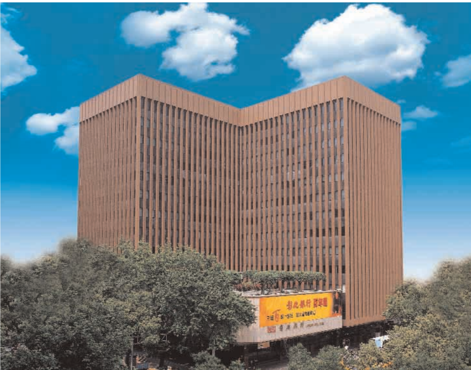
台北總行大樓 CHB Taipei Main Office
